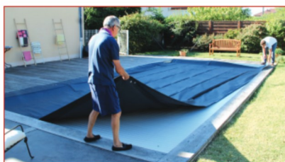
Poser sur le tablier et tendre
