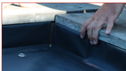
Renforcer les angles avec la mousse fournie
