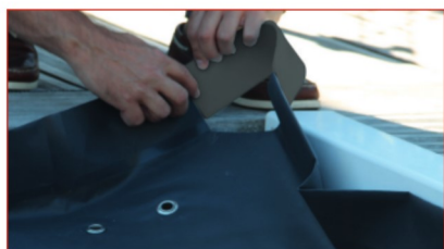
Renforcer les angles avec la mousse fournie
